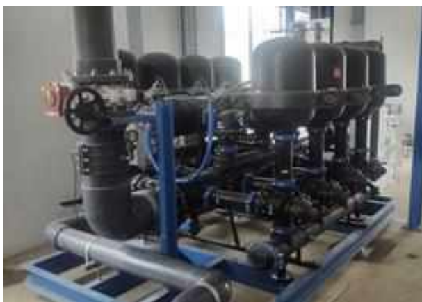
Ilustración 3 - Filtros de Anilla Auto limpiantes
