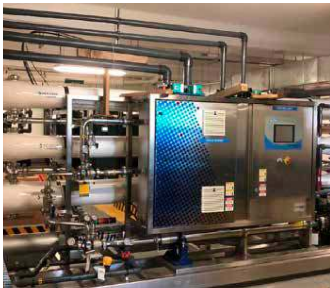
Figura 1. Planta de osmosis inversa construida por Water Technologies de Mexico capaz de recuperar 60%.
