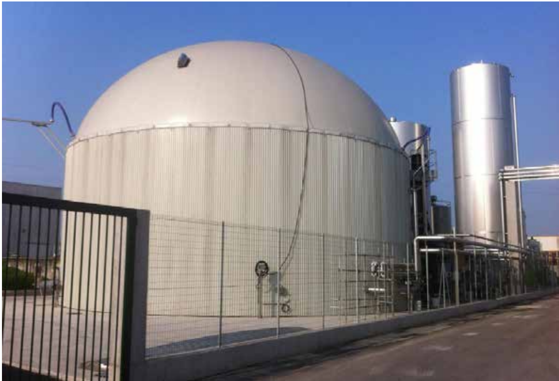
Establecimiento lácteo: Digestor anaeróbico de suero de leche para 100m 3 /día de suero de leche para producir 7200 KWh/día de energía eléctrica y 7200 KWh/día de energía térmica
