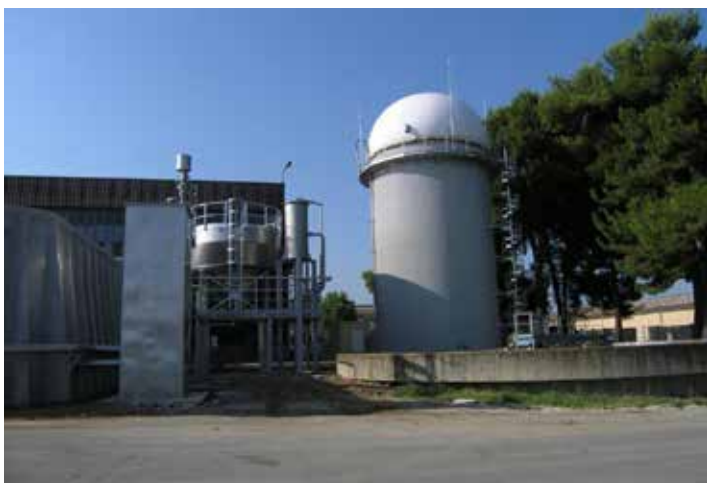
Molino de papel: Reactor EFC a la izquierda y planta de acabado aeróbico a la derecha
