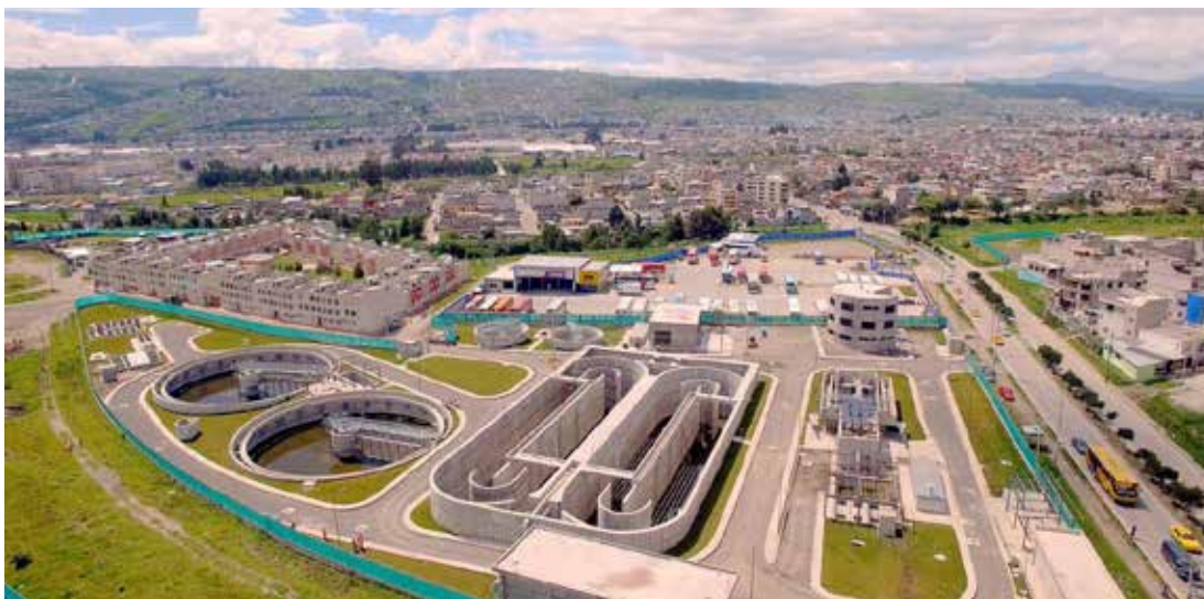
PTAR de Quitumbe inaugurada en 2017 manifiesta la voluntad de avanzar en metas nacionales de tratamiento.
