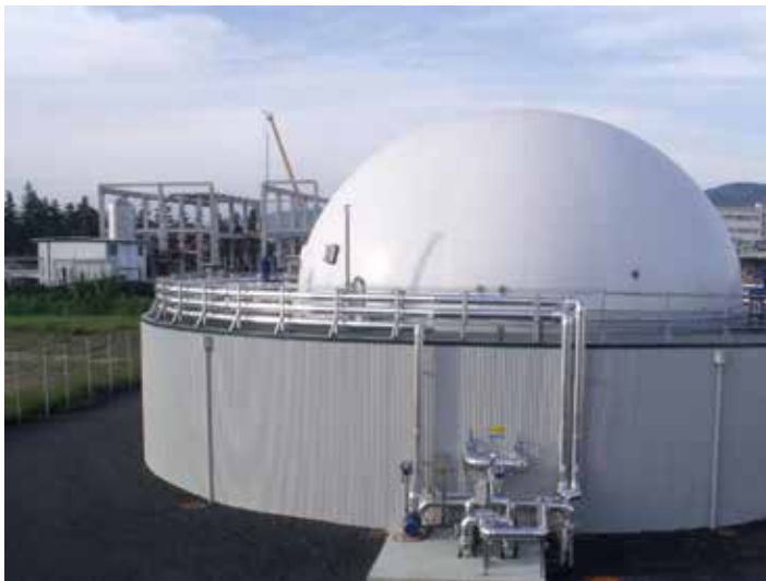
Matadero de pollos: digestión anaeróbica de lodos primarios
