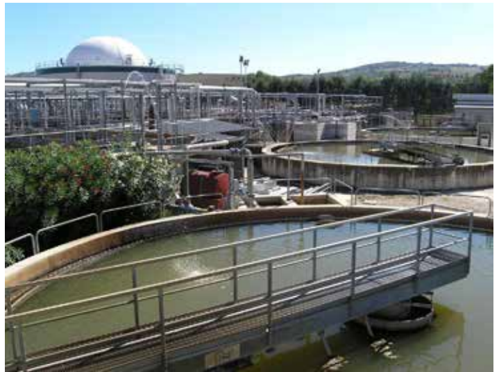
Matadero de pollos: Modificación de una planta de nitrificación-desnitrificación con un nuevo sistema de aireación y digestión anaeróbica de lodos. Proyecto finalizado sin ninguna interrupción de la operación normal de la planta
