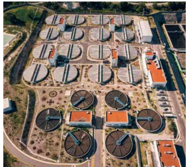
PTAR Atotonilco vista aérea
