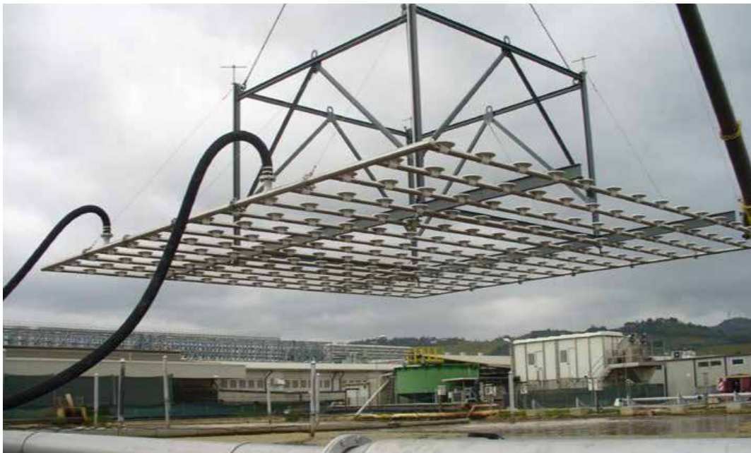
Matadero de pollos: Modernización de una planta de nitrificación / desnitrificación con un nuevo sistema de aireación sin ninguna interrupción de la planta
