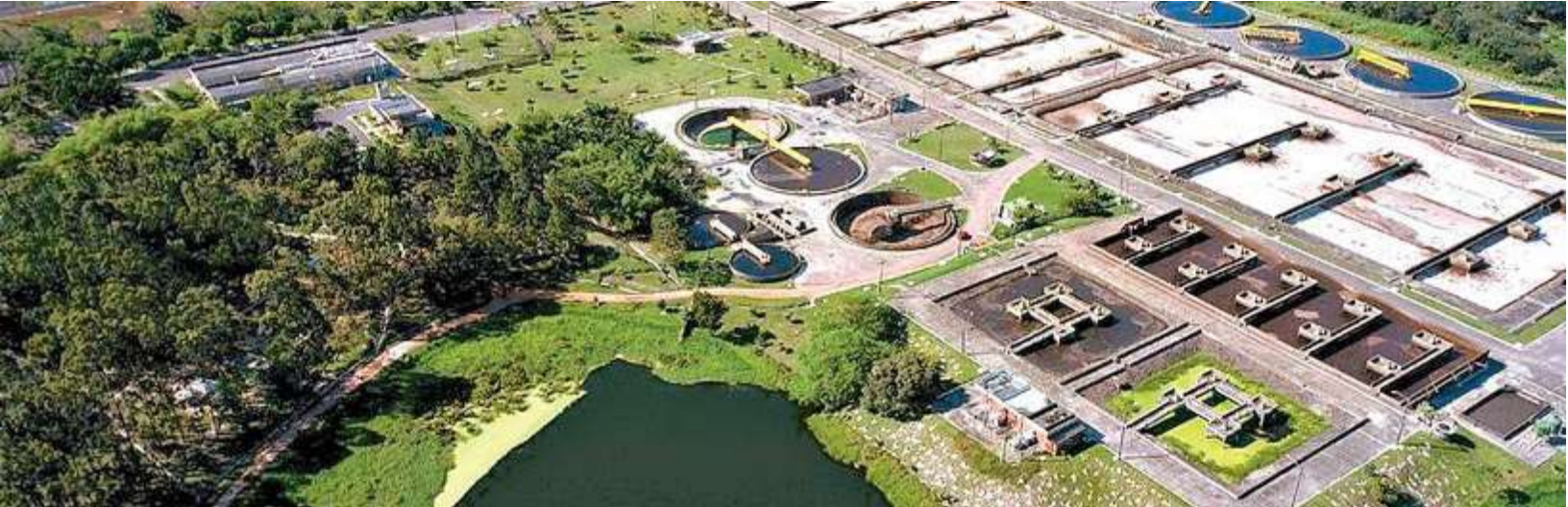
Estação de Tratamento de Água de Camaçari
